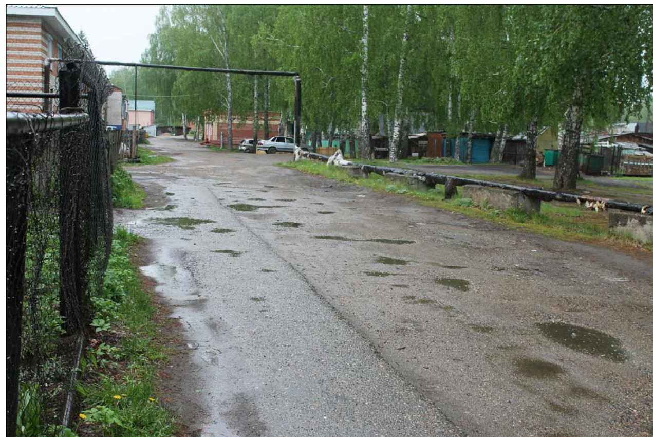
Фотофиксация существующих проездов
